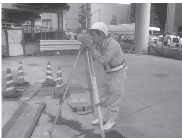
写真3 インターンシップでの現場作業状況
